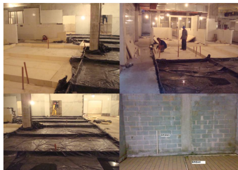
Figura 2.1 – Câmara fria em alvenaria
