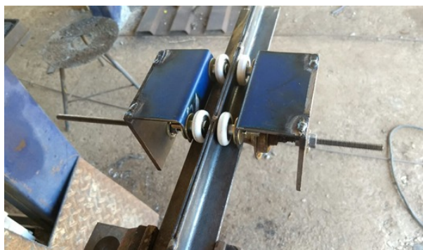
Figura 14 – Montagem da talha.
