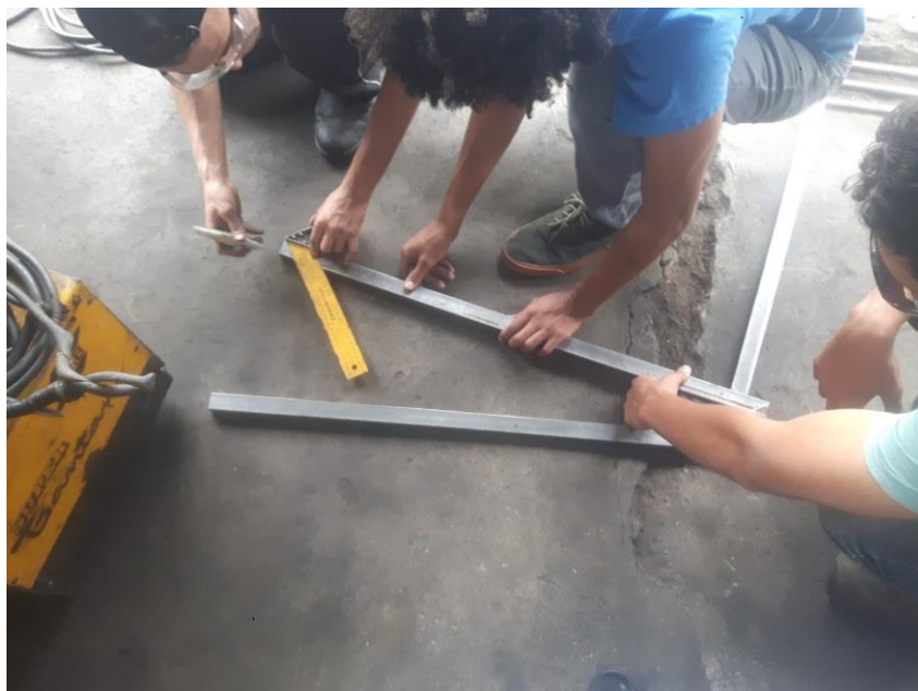
Figura 4: Medição das peças para montagem do chassi.
