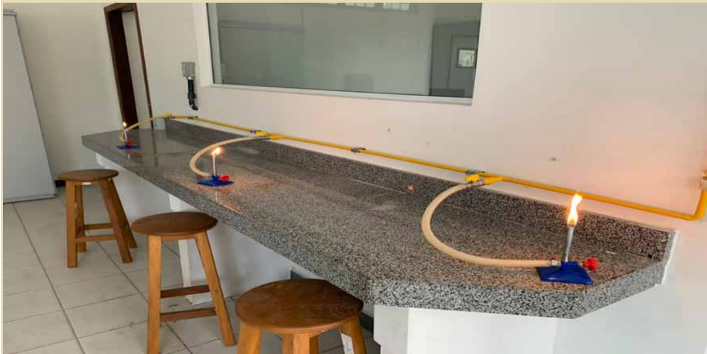
Instalação de rede de gás para os Laboratório de Química.
