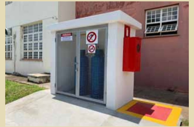
Instalação de rede de gás para os Laboratório de Química.
