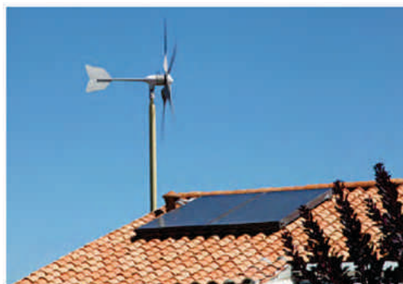
Figura: Sistema Híbrido 3 - Eólica-solar
