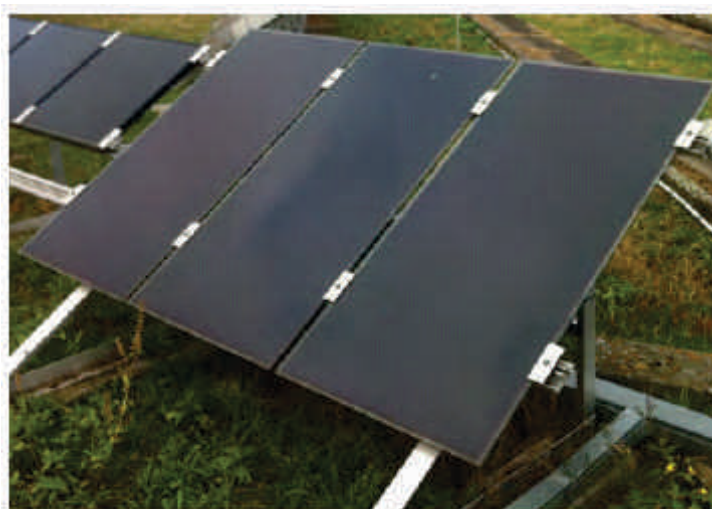
Figura: Estrutura de suporte autoportante.
