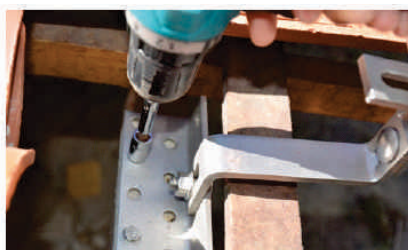
Figura: Montagem da fixação do gancho no caibro.
