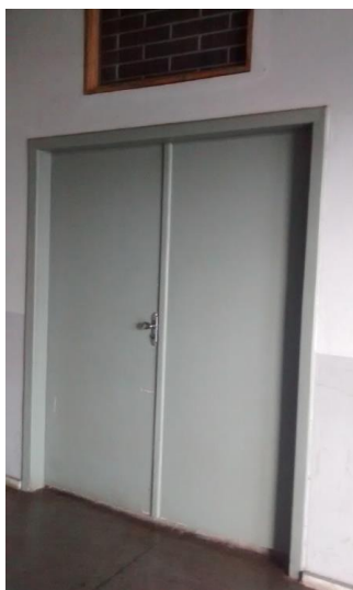
Espaço destinado à instalação de elevador (na caixa de escada)
