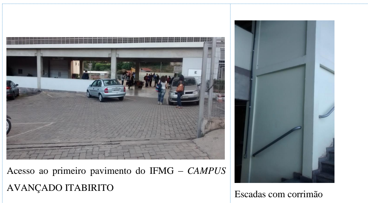
Figura 9 – Acessibilidade no IFMG – CAMPUS AVANÇADO ITABIRITO.
