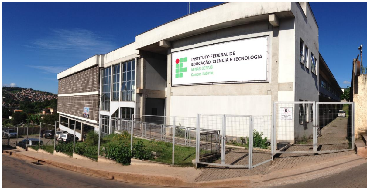
Figura 8- Fachada frontal do prédio e rampa de acesso ao segundo pavimento.
