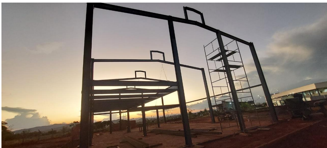
Figura 10 – Prédio 2 em construção, em 24/10/2022
