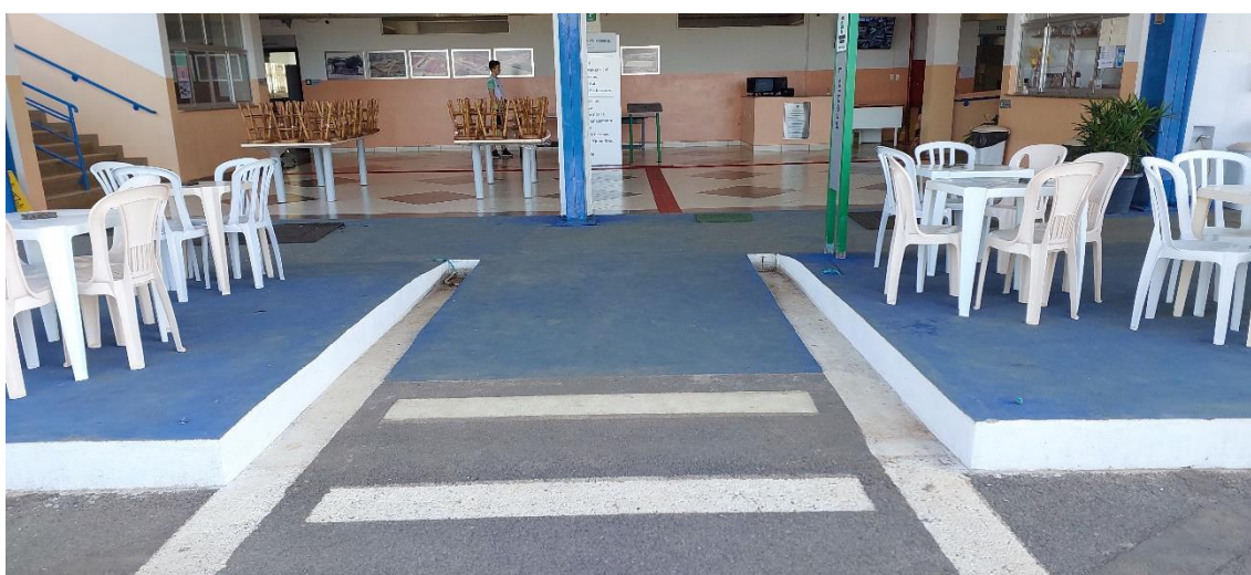
Figura 15 - Rampa de acesso às dependências da instituição
