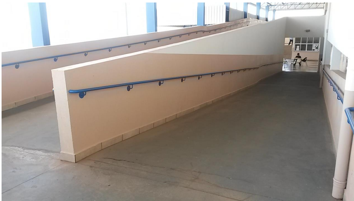
Figura 11 - Rampa de acesso ao segundo andar
