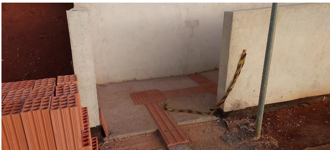
Figura 22 – Detalhe da sinalização podotátil na rampa de transposição de nível entre os prédios 1 (existente) e 2 (em construção)
