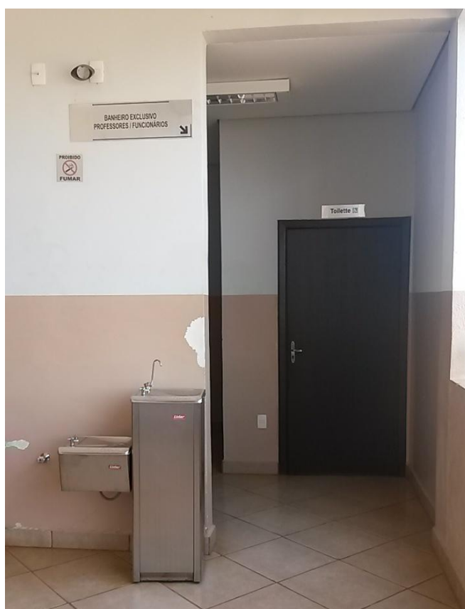
Figura 19 - Vista geral do banheiro para P.N.E
