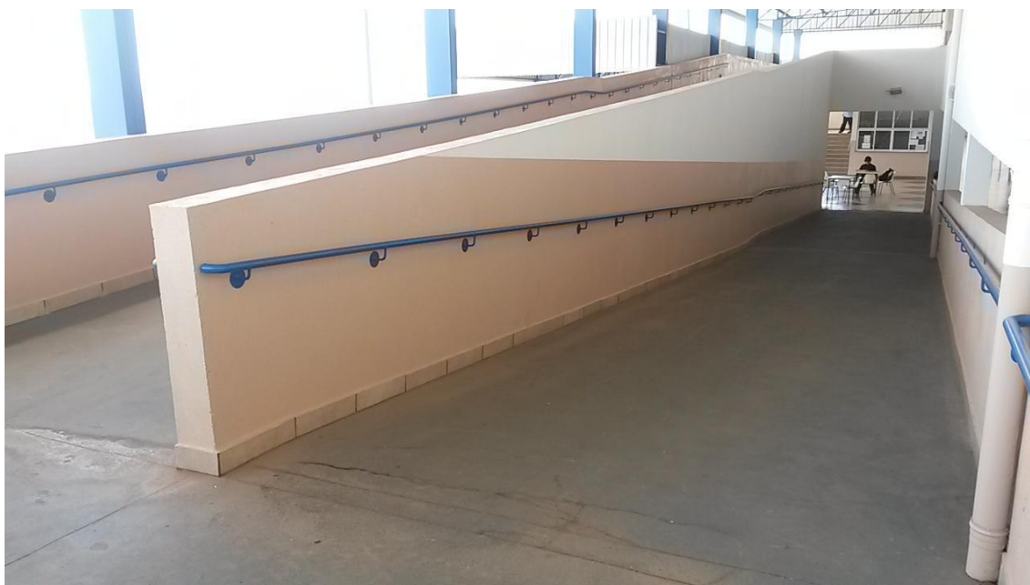
Figura 11 - Rampa de acesso ao segundo andar
