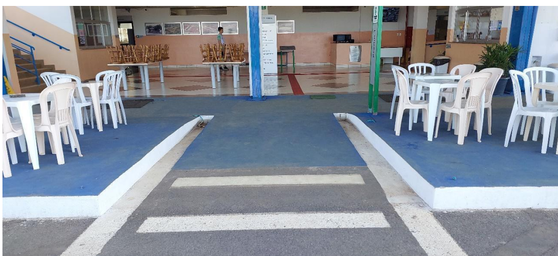
Figura 15 - Rampa de acesso às dependências da instituição
