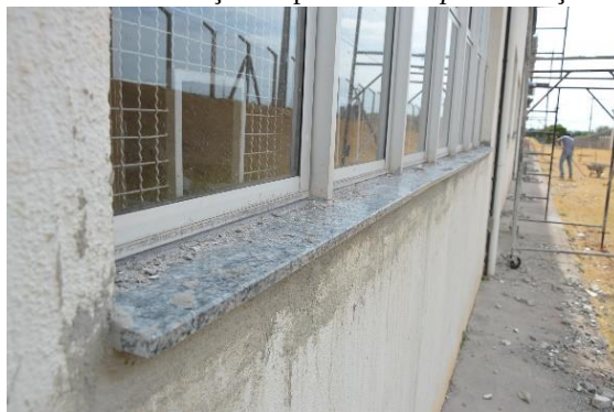
Figura 58 - Vista instalação de peitoril Campus Avançado Piumhi
