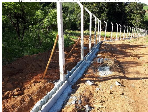
Figura 30 - Vista Lateral 1 - Cercamento
