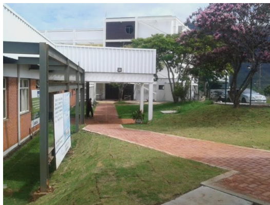
Figura 47 i Vista externa do Tratamento de fachada do Bloco 1
