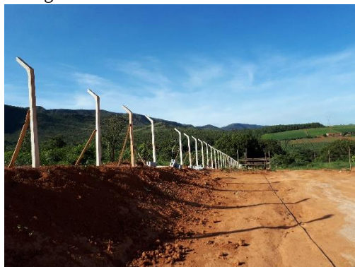
Figura 28 - Vista Frontal 1 - Cercamento
