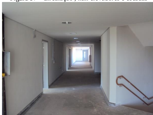
Figura 97 - Circulação , hall elevadores e escadas
