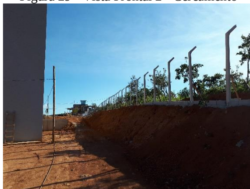
Figura 29 - Vista Frontal 2 - Cercamento
