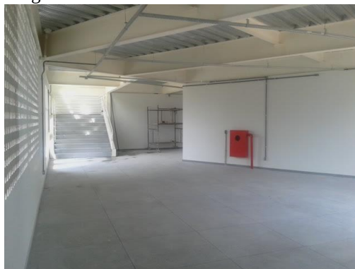
Figura 50 - Vista Interna 1 ã Bloco Didático
