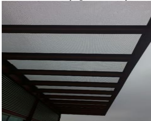
Figura 26 - Vista externa do pergolado do Campus Congonhas
