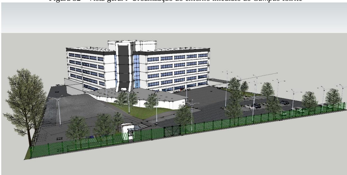
Figura 32 - Vista geral i Urbanização do entorno imediato do Campus Ibirité
