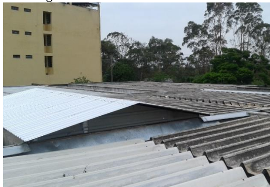
Figura 54 - Vista do telhado reformado
