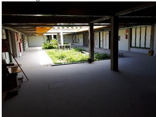
Figura 74 - Vista interna i Bloco III
