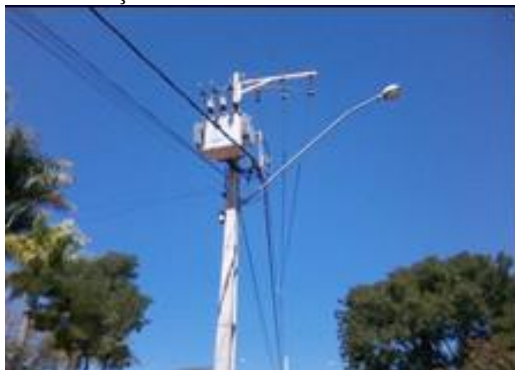
Figura 84 - Instalação de transformadores em São João Evangelista
