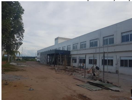
Figura 37 - Vista frontal reforma Campus Avançado Ipatinga
