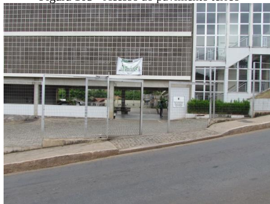
Figura 105 - Acesso ao pavimento térreo
