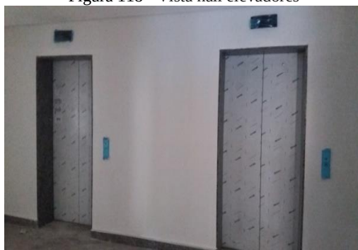
Figura 118 - Vista hall elevadores
