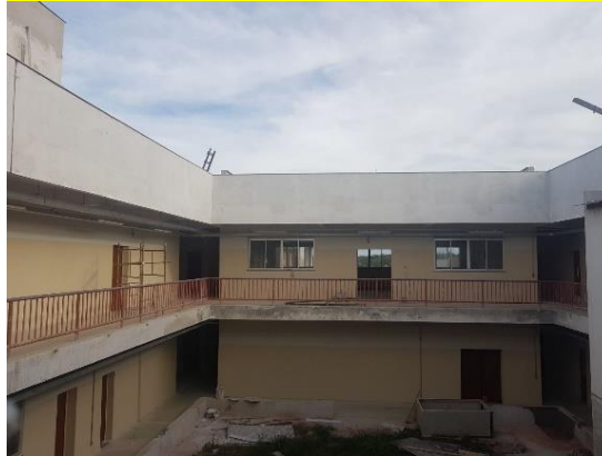
Figura 38 - Vista interna Pátio Central Campus Avançado Ipatinga
