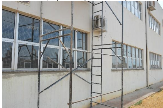
Figura 57 - Vista lateral, reparos esquadrias Campus Avançado Piumhi
