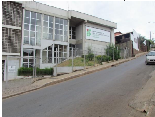
Figura 104 - Vista fachada do Campus.
