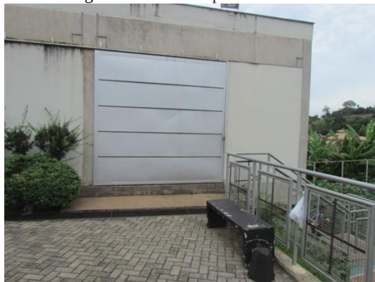
Figura 107 - Acesso palco auditório
