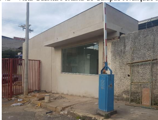
Figura 42 - Vista Guarita/Portaria do Campus Avançado Ipatinga
