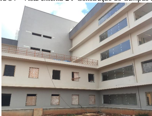
Figura 34 - Vista externa 2 Construção do Campus Ibirité
