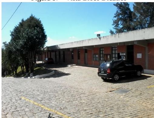
Figura 87 - Vista Bloco Didático
