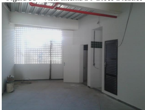
Figura 51 - Vista Interna 2 ã Bloco Didático
