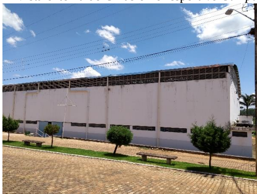
Figura 24 - Vista externa do Ginásio Poliesportivo Campus Bambuí
