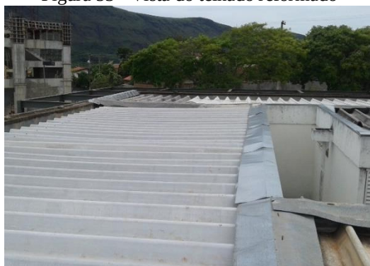
Figura 53 - Vista do telhado reformado
