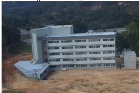
Figura 116 - Vista geral da obra
