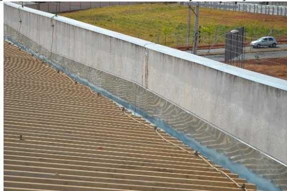
Figura 56 - Vista telhado e calha Campus Avançado Piumhi
