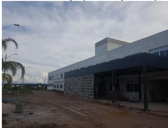
Figura 39 - Vista externa ampliação do Campus Avançado Ipatinga
