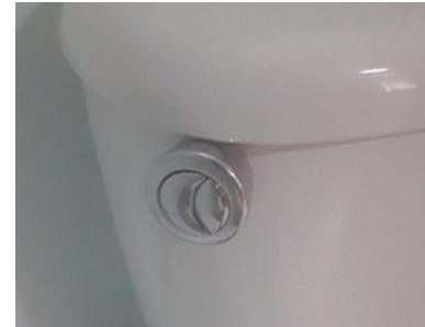
Fig. 04: Descargas com caixa acoplada dotadas de acionamento duplo para redução do consumo de água.
