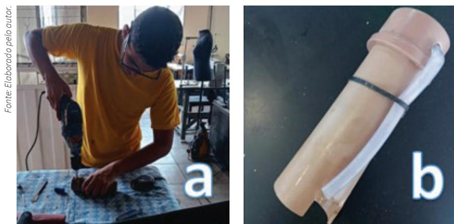
**Figura 2 .** (a) Furo para o encaixe da mangueira de nível no sifão
