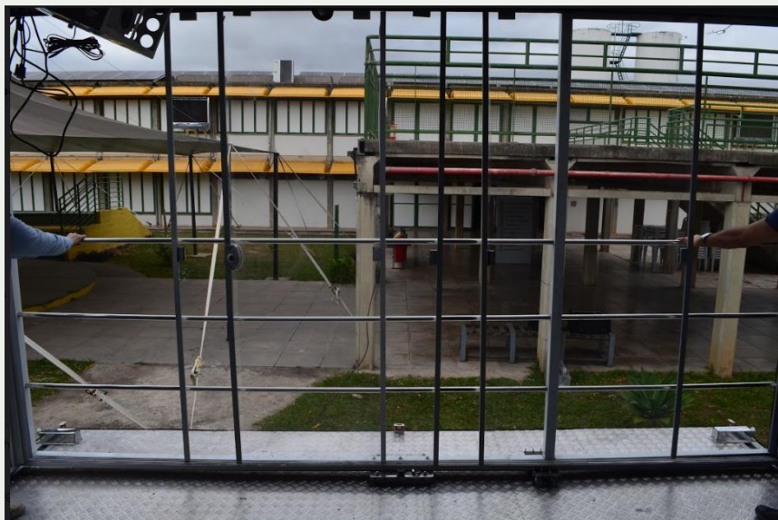
Figura 26: Estrutura já aberta
