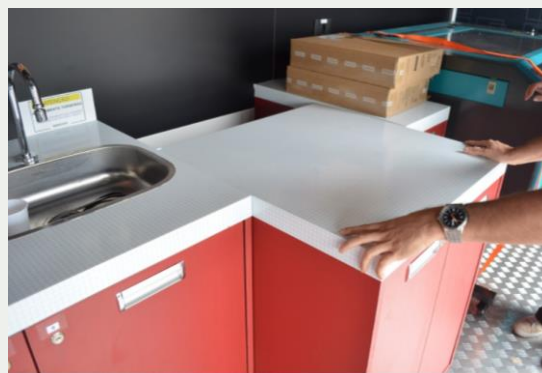
Figura 36: Colocação do armário 2 no lugar
