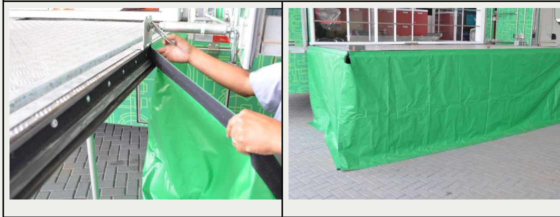
Figura 23: Instalação da capa de proteção da plataforma
