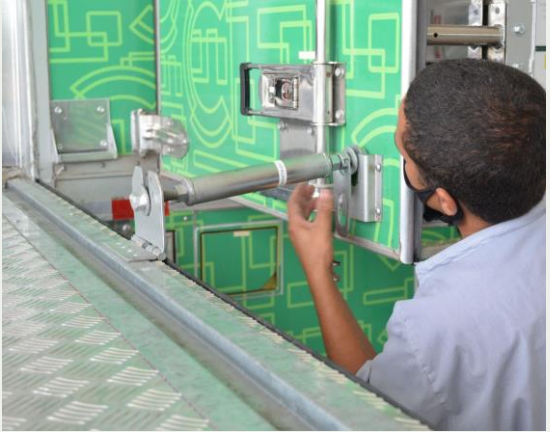
Figura 31: Instalação do extensor
