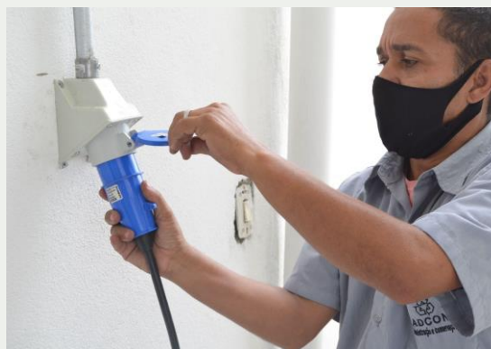
Figura 42: Ligação do caminhão na tomada
