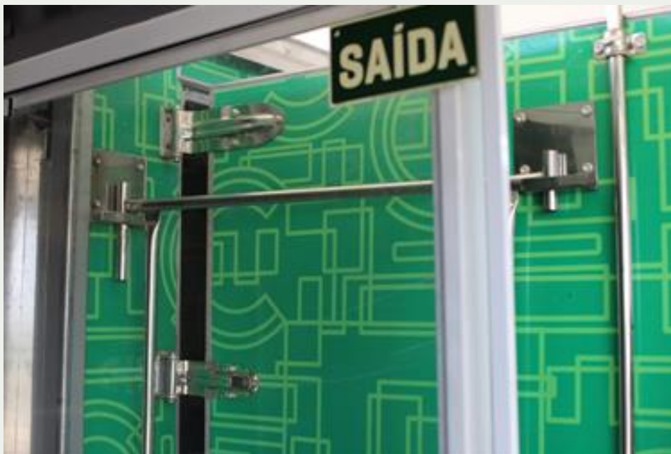
Figura 30: Trava da porta PNE completamente instalada
