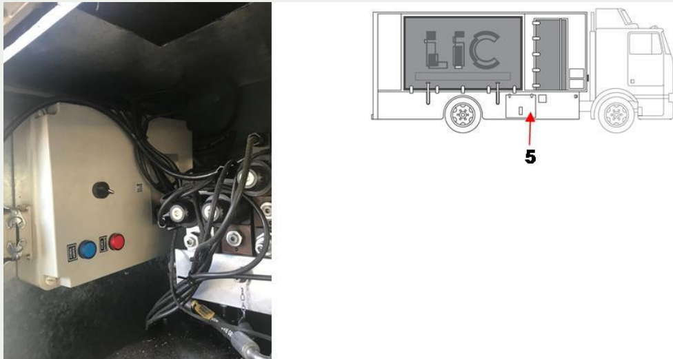
Figura 13: Central de energia do LIC
