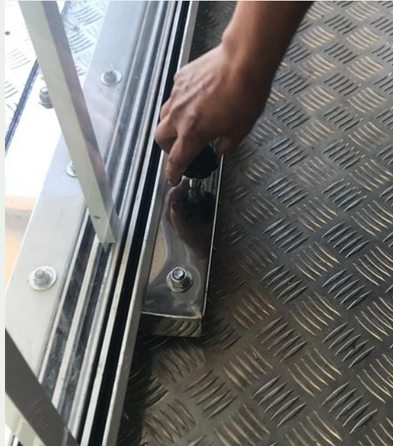
Figura 25: Destravamento da cabine
