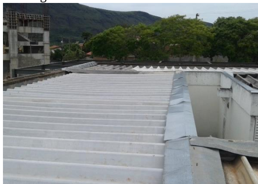
Figura 53 - Vista do telhado reformado
