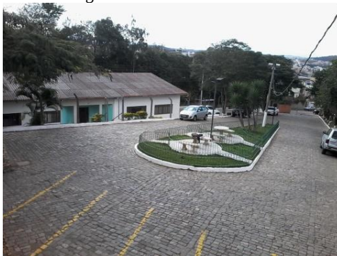
Figura 89 - Vista vias internas
