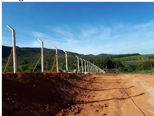
Figura 28 - Vista Frontal 1 - Cercamento
