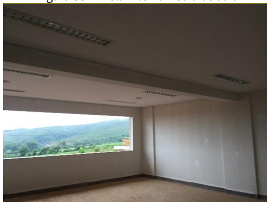
Figura 35 - Vista interna - Sala de aula
