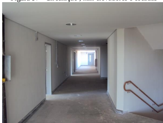
Figura 97 - Circulação , hall elevadores e escadas
