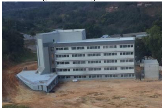
Figura 116 - Vista geral da obra
