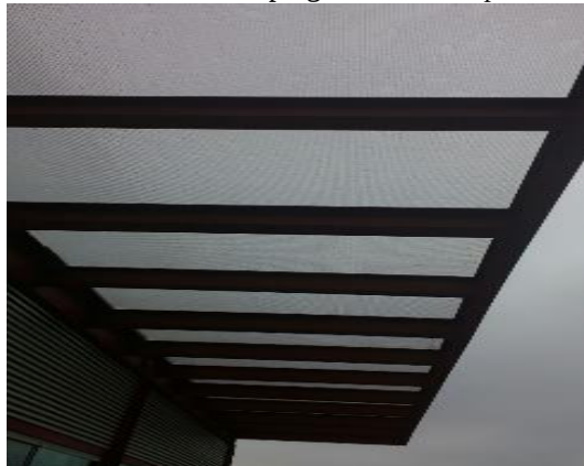
Figura 26 - Vista externa do pergolado do Campus Congonhas
