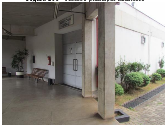
Figura 106 - Acesso principal auditório
