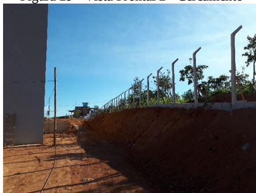
Figura 29 - Vista Frontal 2 - Cercamento
