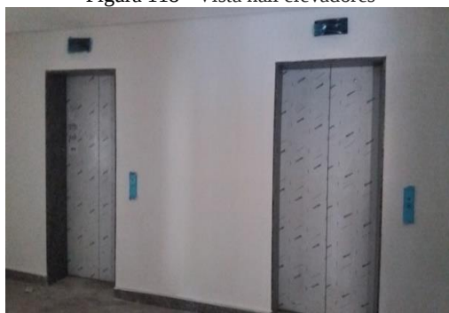
Figura 118 - Vista hall elevadores
