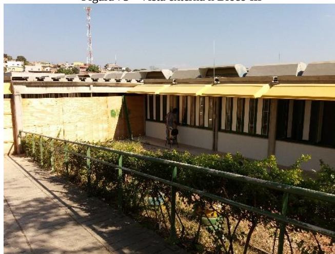
Figura 73 - Vista externa ã Bloco III
