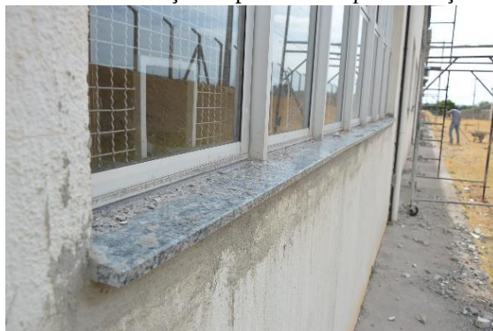
Figura 58 - Vista instalação de peitoril Campus Avançado Piumhi
