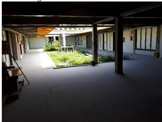
Figura 74 - Vista interna ã Bloco III
