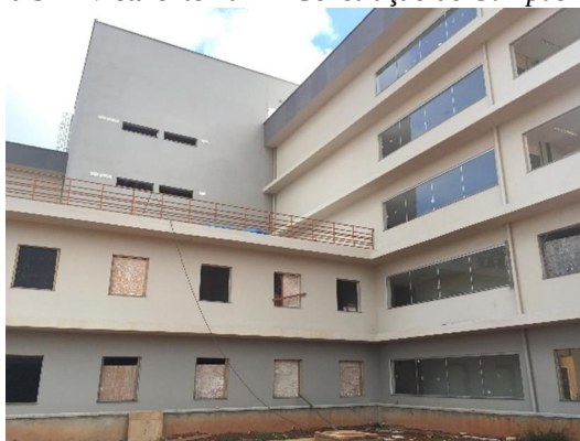
Figura 34 - Vista externa 2 ã Construção do Campus Ibirité
