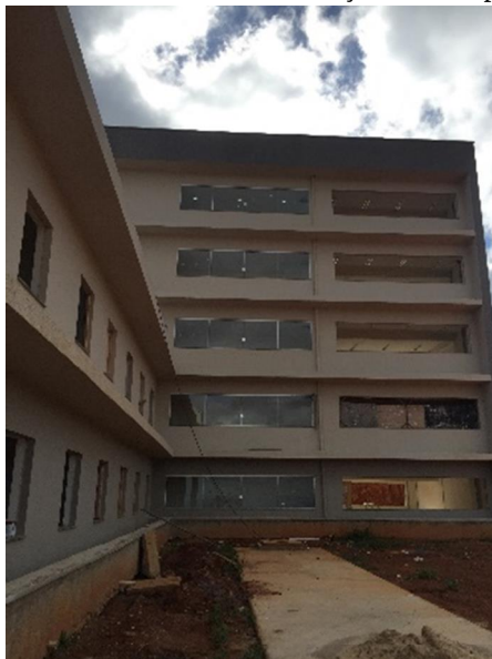
Figura 36 - Vista externa 3ª Construção do Campus Ibirité
