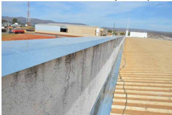
Figura 55 - Vista reforma telhado Campus Avançado Piumhi
