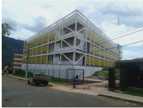
Figura 49 - Vista Externa 2º Bloco Didático
