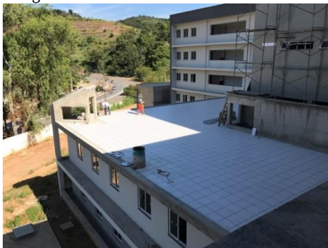
Figura 117 - Vista exterior do Bloco Didático
