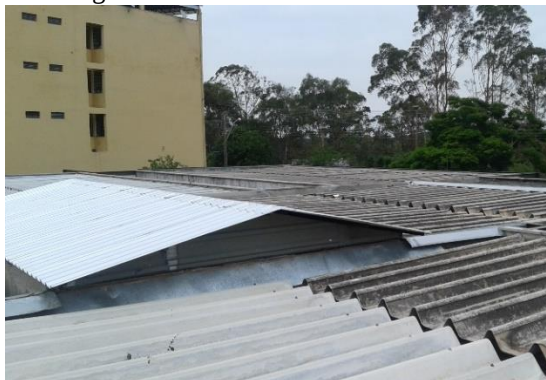
Figura 54 - Vista do telhado reformado
