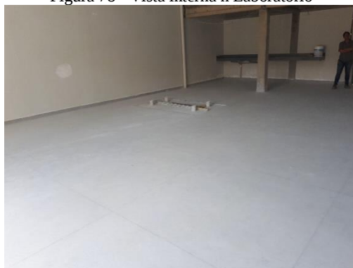
Figura 78 - Vista interna ã Laboratório
