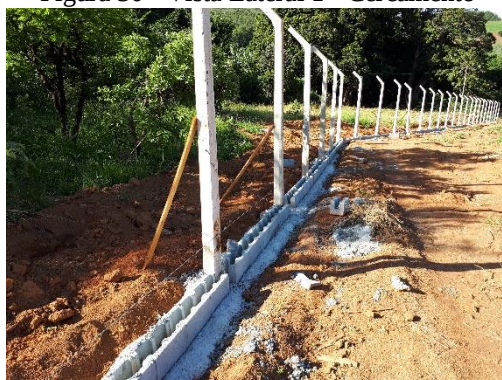
Figura 30 - Vista Lateral 1 - Cercamento
