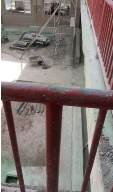
Figura 127 - Inspeção da obra do Campus de Ipatinga
