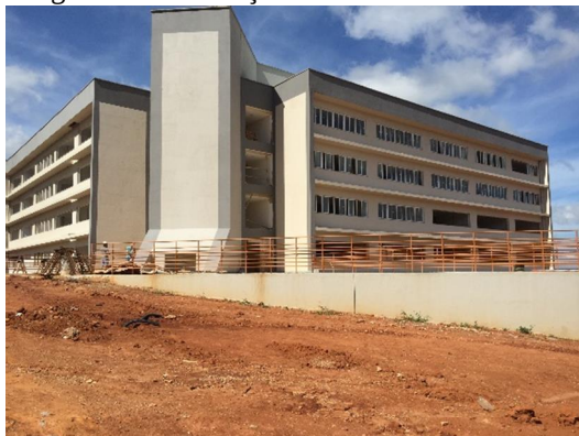
Figura 33 - Vista geral ã Urbanização do entorno imediato do Campus Ibirité
