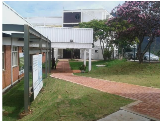
Figura 47 - Vista externa do Tratamento de fachada do Bloco 1
