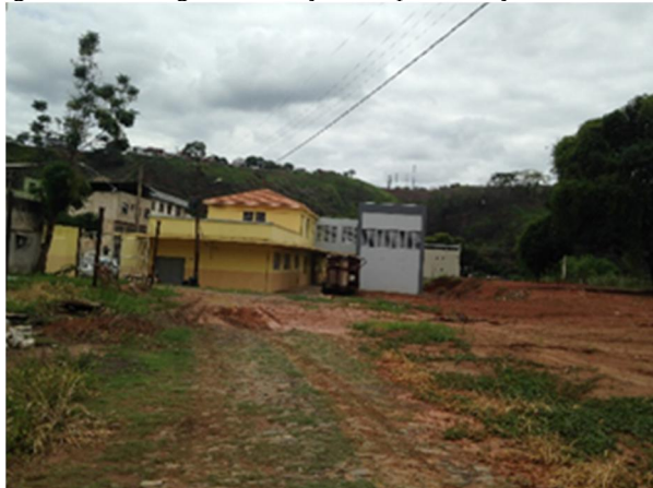
Figura 61 - Vista geral edificação Campus Avançado Ponte Nova
