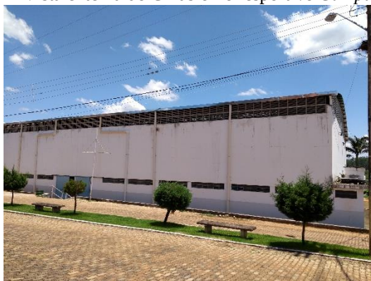
Figura 24 - Vista externa do Ginásio Poliesportivo Campus Bambuí
