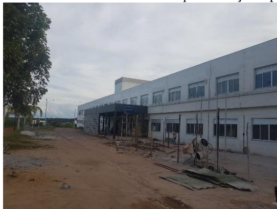
Figura 37 - Vista frontal reforma Campus Avançado Ipatinga
