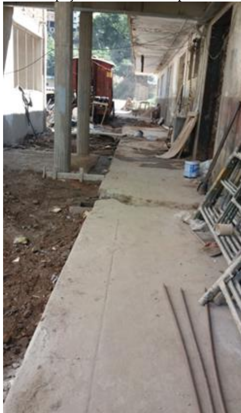
Figura 128 - Inspeção da obra do Campus de Ponte Nova
