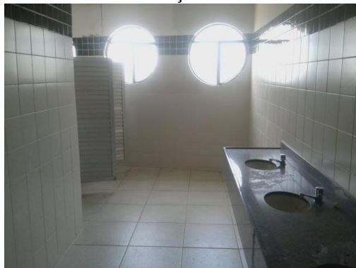
Figura 52 - Vista interna Instalações Sanitárias do Bloco Didático
