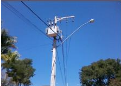
Figura 84 - Instalação de transformadores em São João Evangelista
