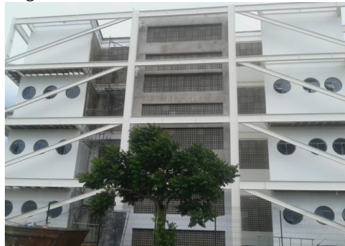
Figura 48 - Vista Externa 1 - Bloco Didático
