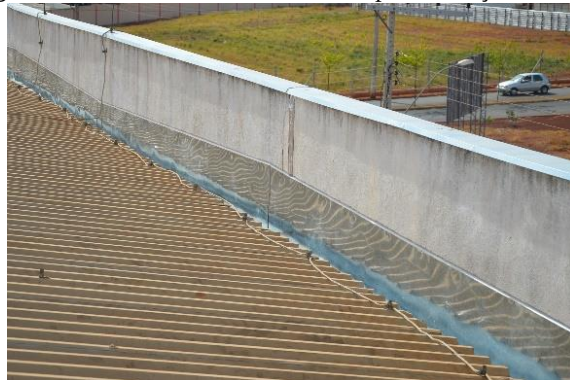
Figura 56 - Vista telhado e calha Campus Avançado Piumhi
