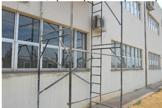
Figura 57 - Vista lateral, reparos esquadrias Campus Avançado Piumhi
