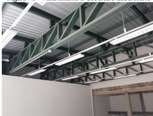
Figura 76 - Vista interna ã Cobertura Laboratório
