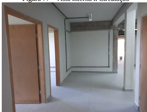
Figura 77 - Vista interna ã Circulação
