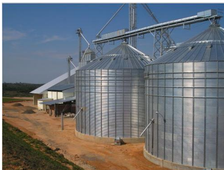
Figura 1 - Silos metálicos de armazenamento da Porto Mineiro de Grãos
